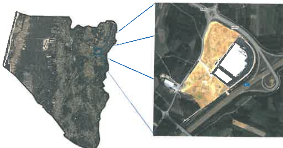
Figura 1 – Enquadramento do Parque Empresarial de Soza – Parcela A no Município de Vagos
