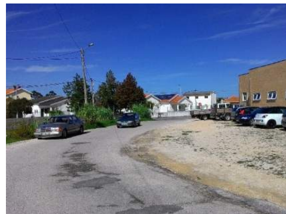
Figura 47 – Pavimento da faixa de rodagem degradado pelo uso, na Rua da Fonte (à esquerda) e na Rua da Alegria (à direita) Fonte: Cotefis, 2016
