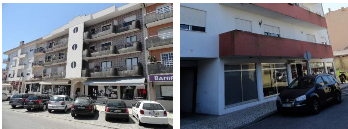
Figura 64 – Comércio de rua e serviços na Rua Padre Vicente Maria da Rocha (à esquerda) e entrada para o Centro Comercial Narciso, pela Rua Carvalho e Maia (à direita) Fonte: Cotefis, 2016
