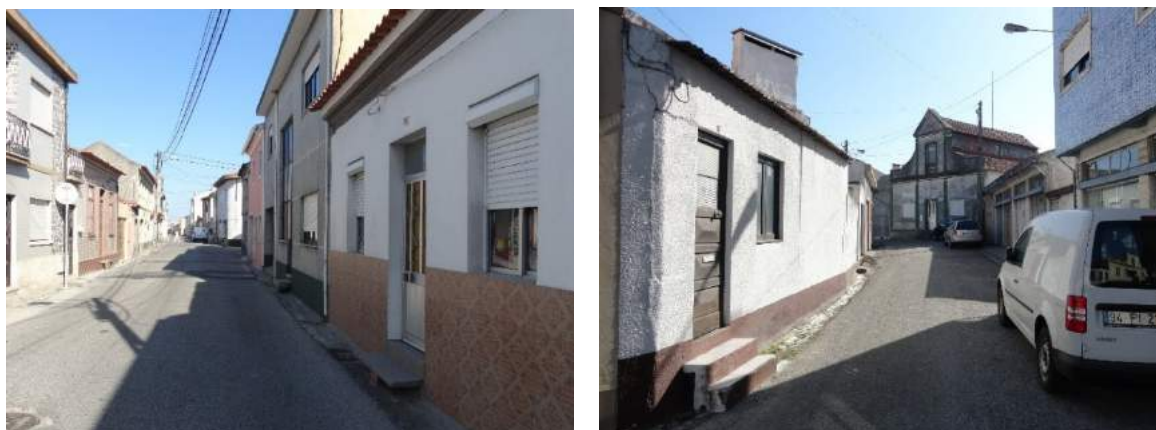
Figura 35 – Degraus de acesso ao edificado: Rua da Fonte (à esquerda) e Rua Dr. Vasco Rocha (à direita) Fonte: Cotefis, 2016
