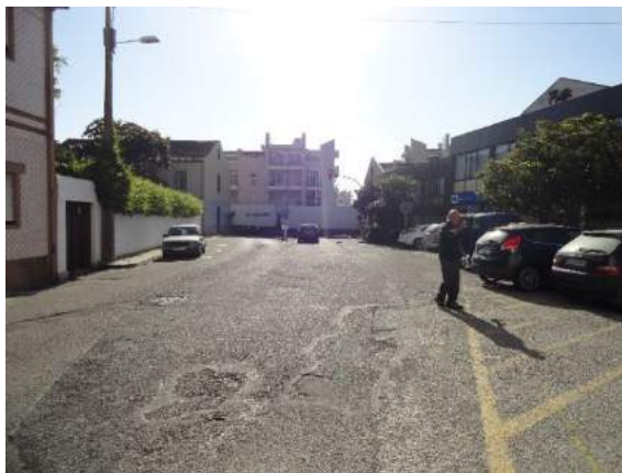
Figura 47 – Pavimento da faixa de rodagem degradado pelo uso, na Rua da Fonte (à esquerda) e na Rua da Alegria (à direita) Fonte: Cotefis, 2016
